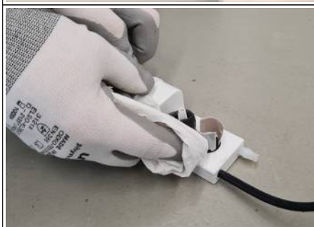
Ill. : 19: Nettoyer la pompe de condensat
